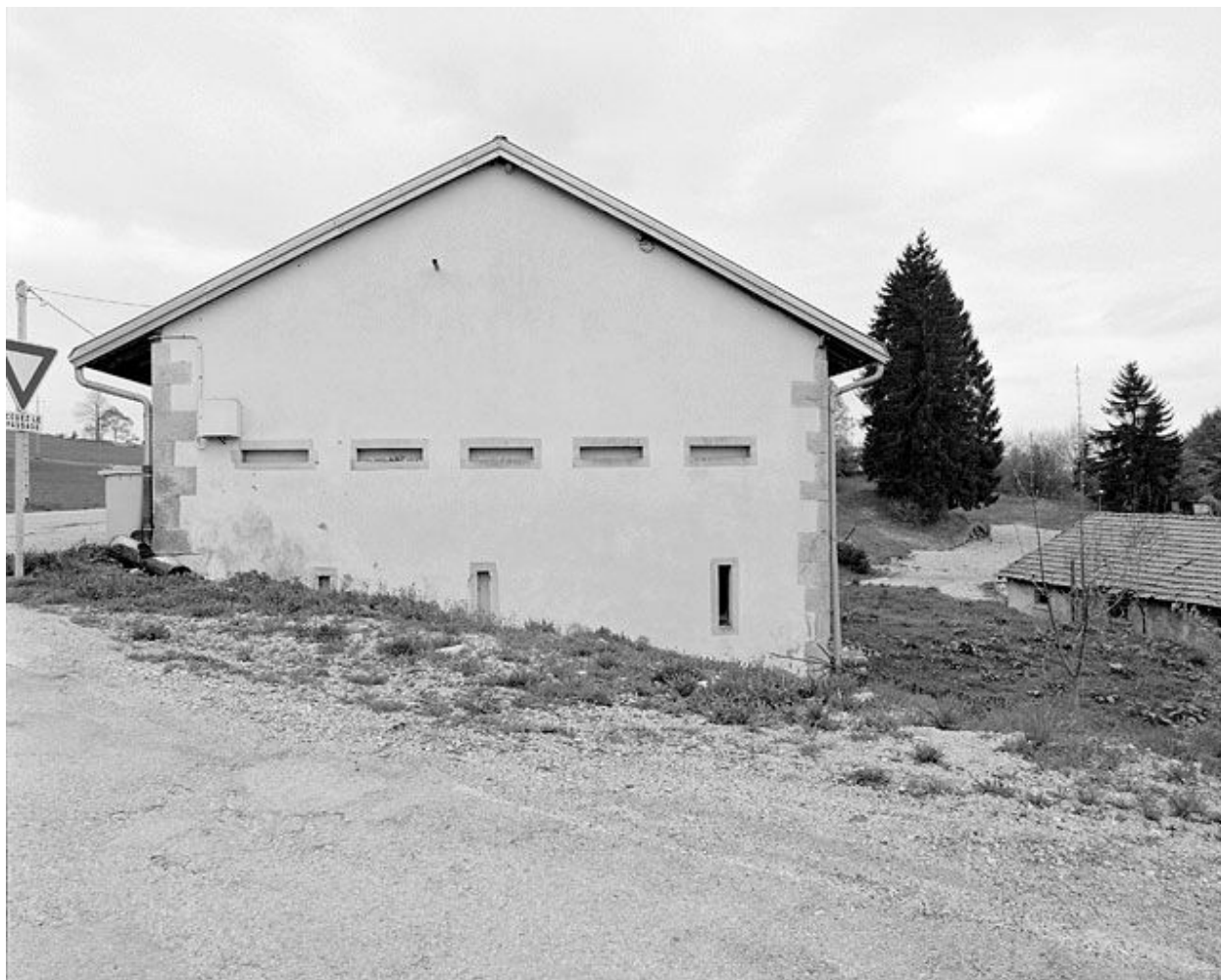
Façade droite de la fromagerie.
