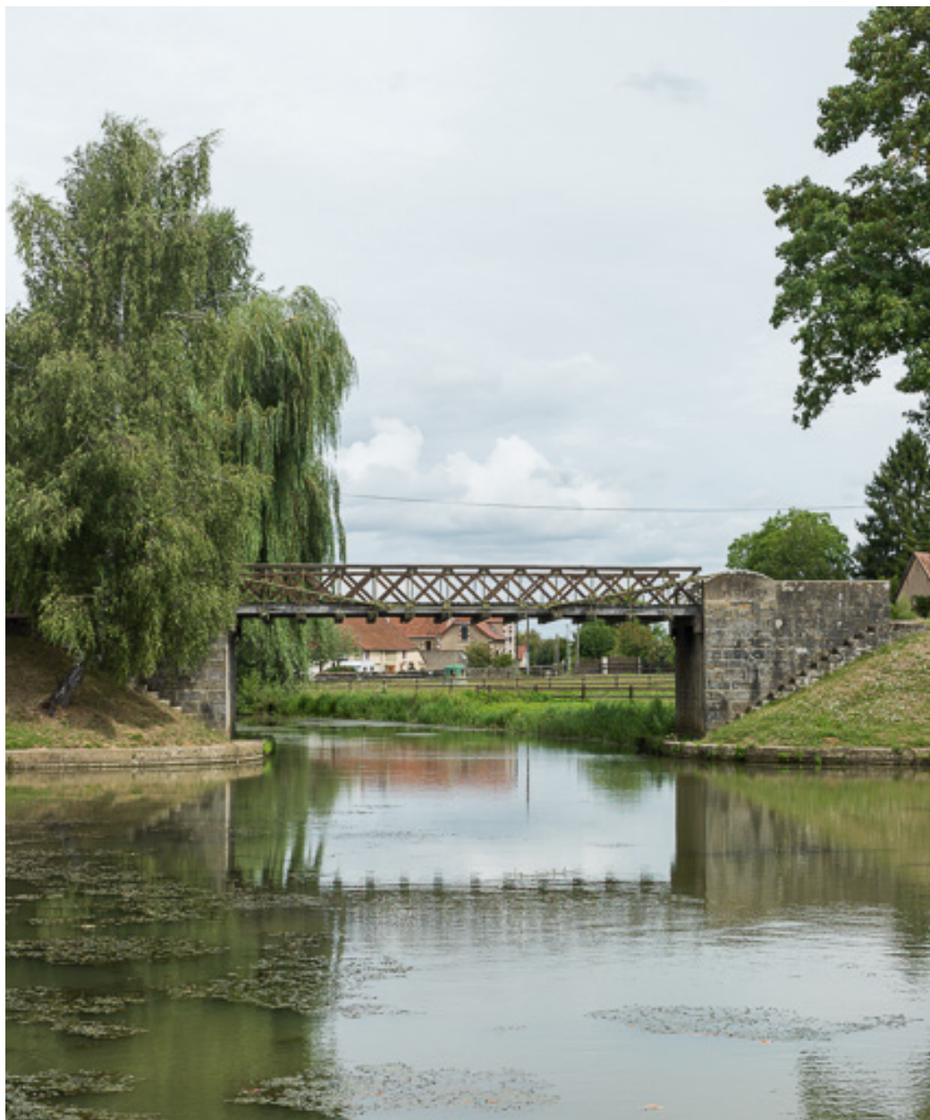
Vue d'ensemble de la passerelle.
