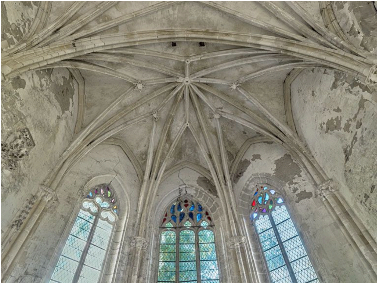
Intérieur de la chapelle : voûtes du choeur.
