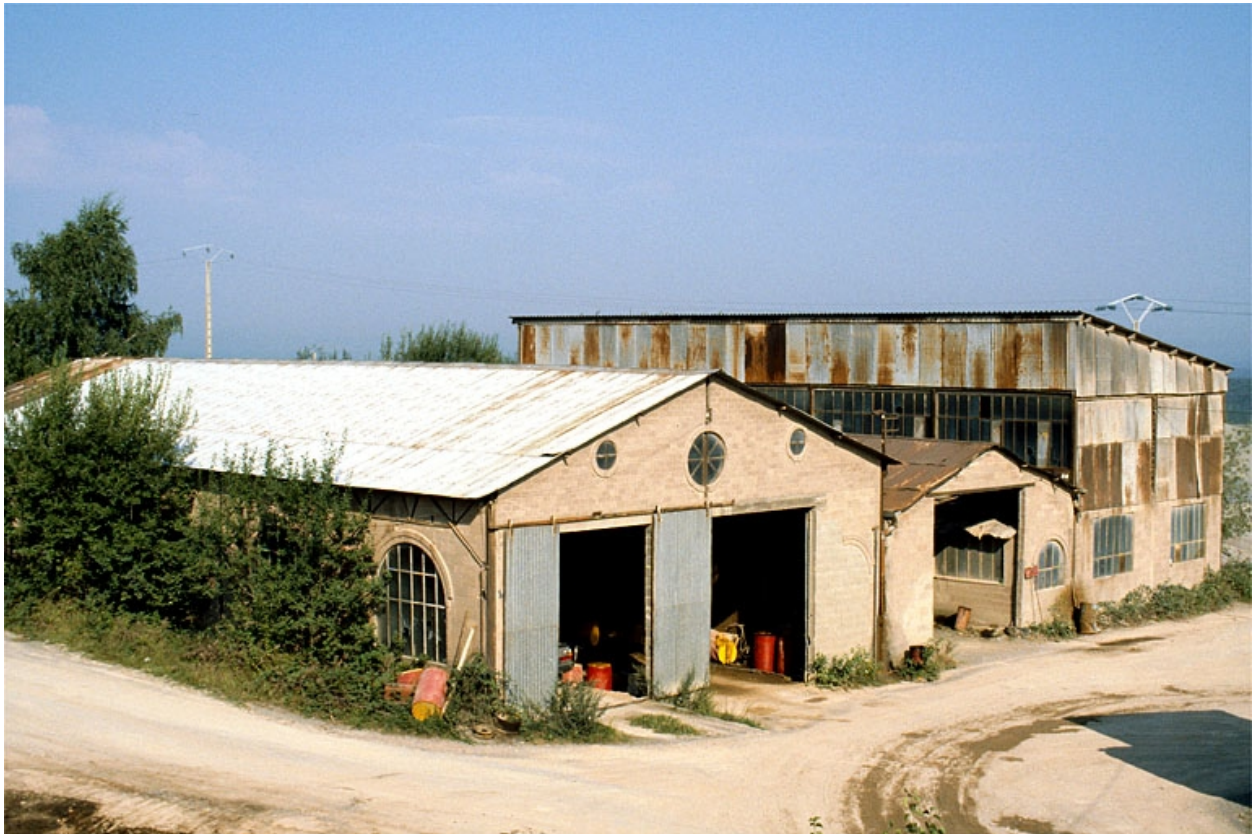
Hangar (G) vu du sud-est, en 1988.
