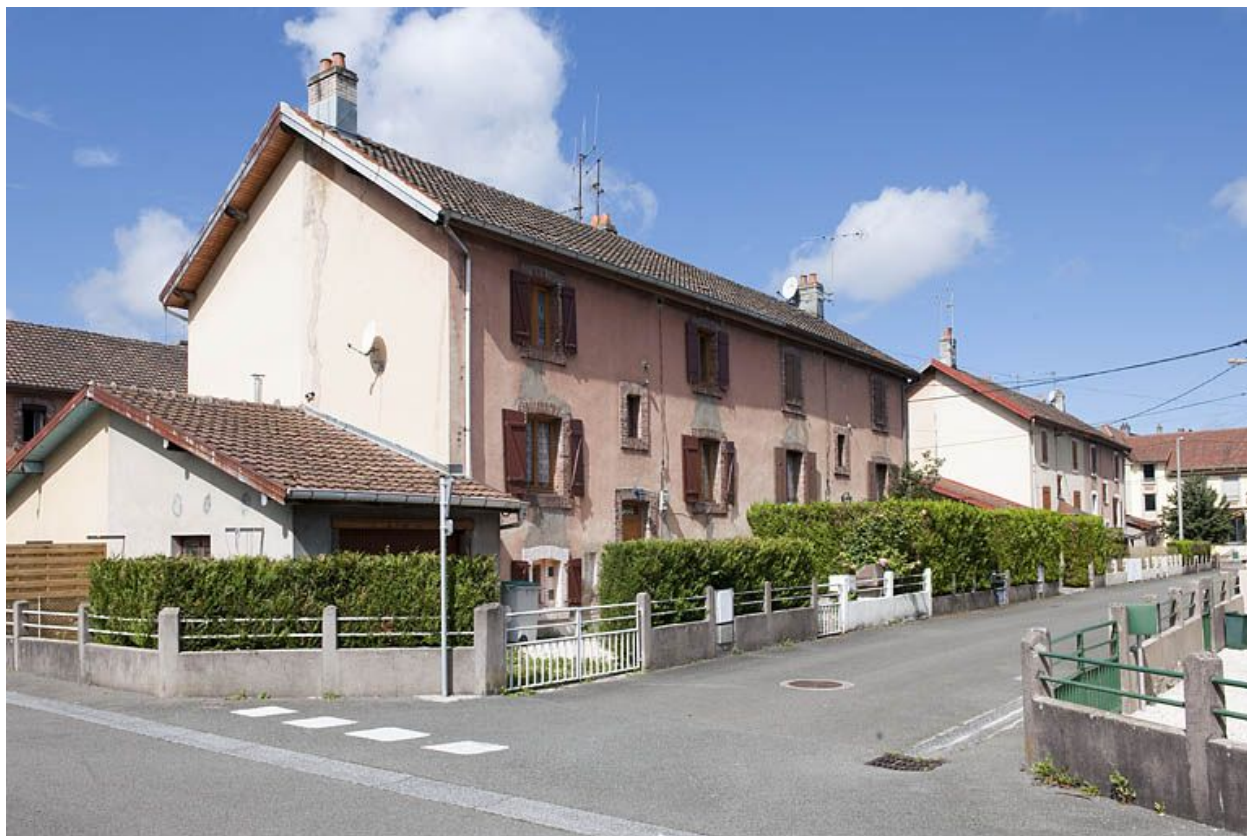
Vue d'ensemble d'une rue.
