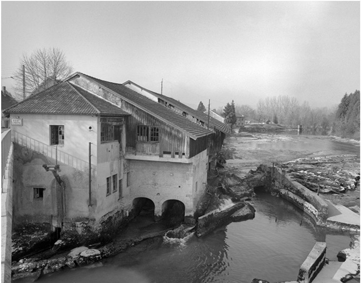
Atelier de fabrication et bâtiment d'eau depuis l'est.
