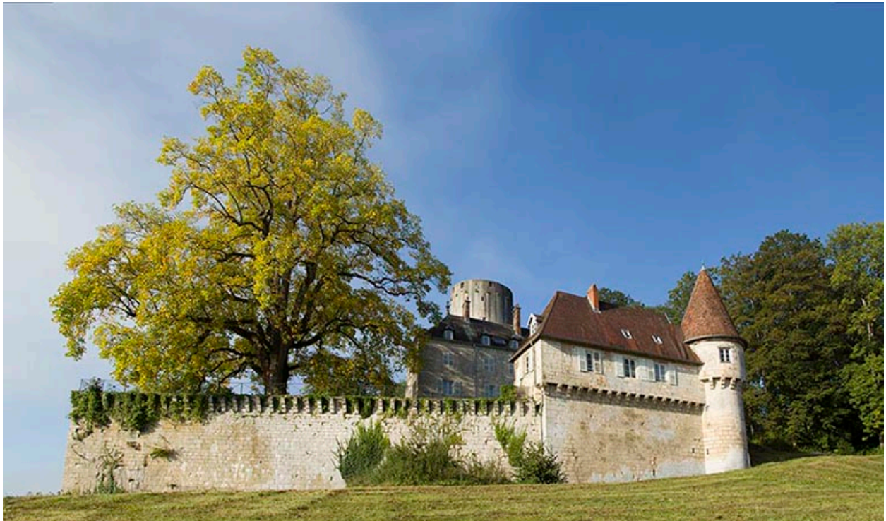
Vue générale nord-est.
