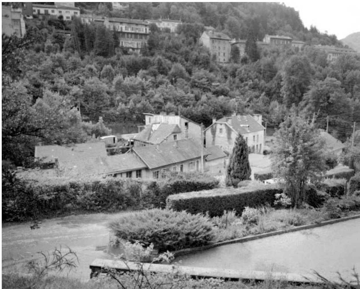
Vue d'ensemble plongeante depuis le nord-ouest.
