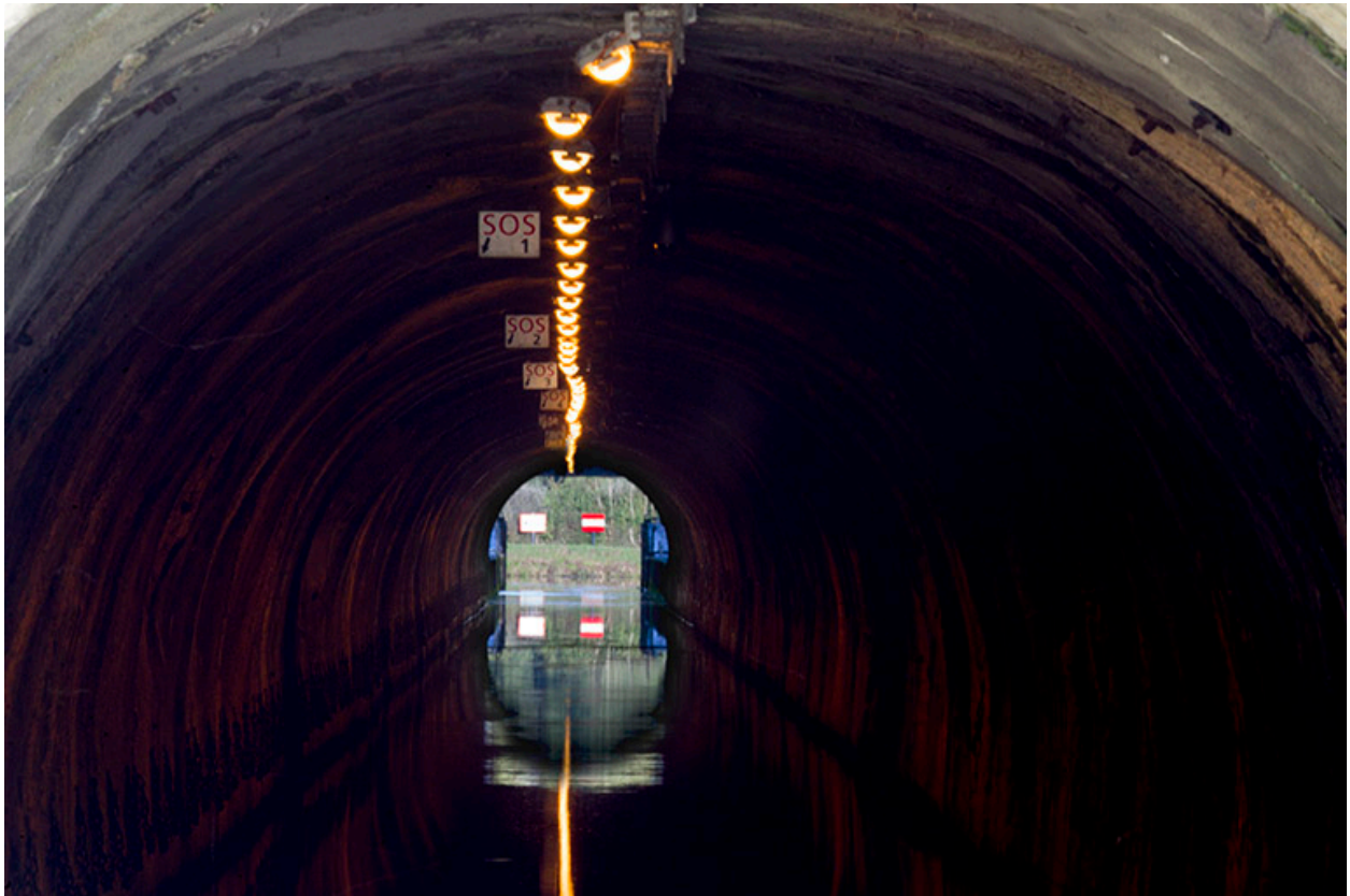
Le tunnel, vue intérieure.
