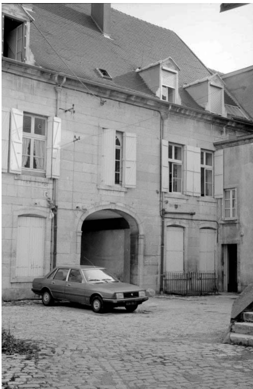
Façade postérieure de l'hôtel.
