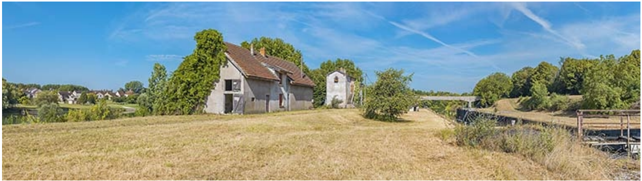
L'ancienne écluse vue depuis l'amont.
