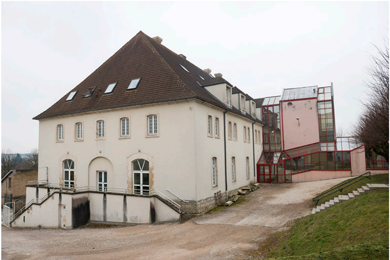
Pignon nord-est du bâtiment de cantine et internat de filles.
