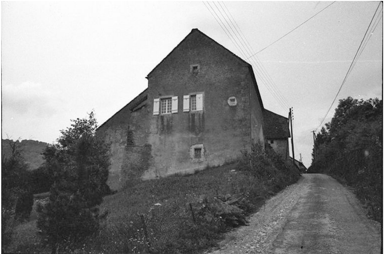
Ferme cadastrée 1960 B 110, située au lieudit La Peyrouse : façade latérale gauche.
