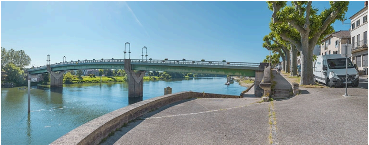
Le pont de Tournus, vu d'amont, rive droite.
