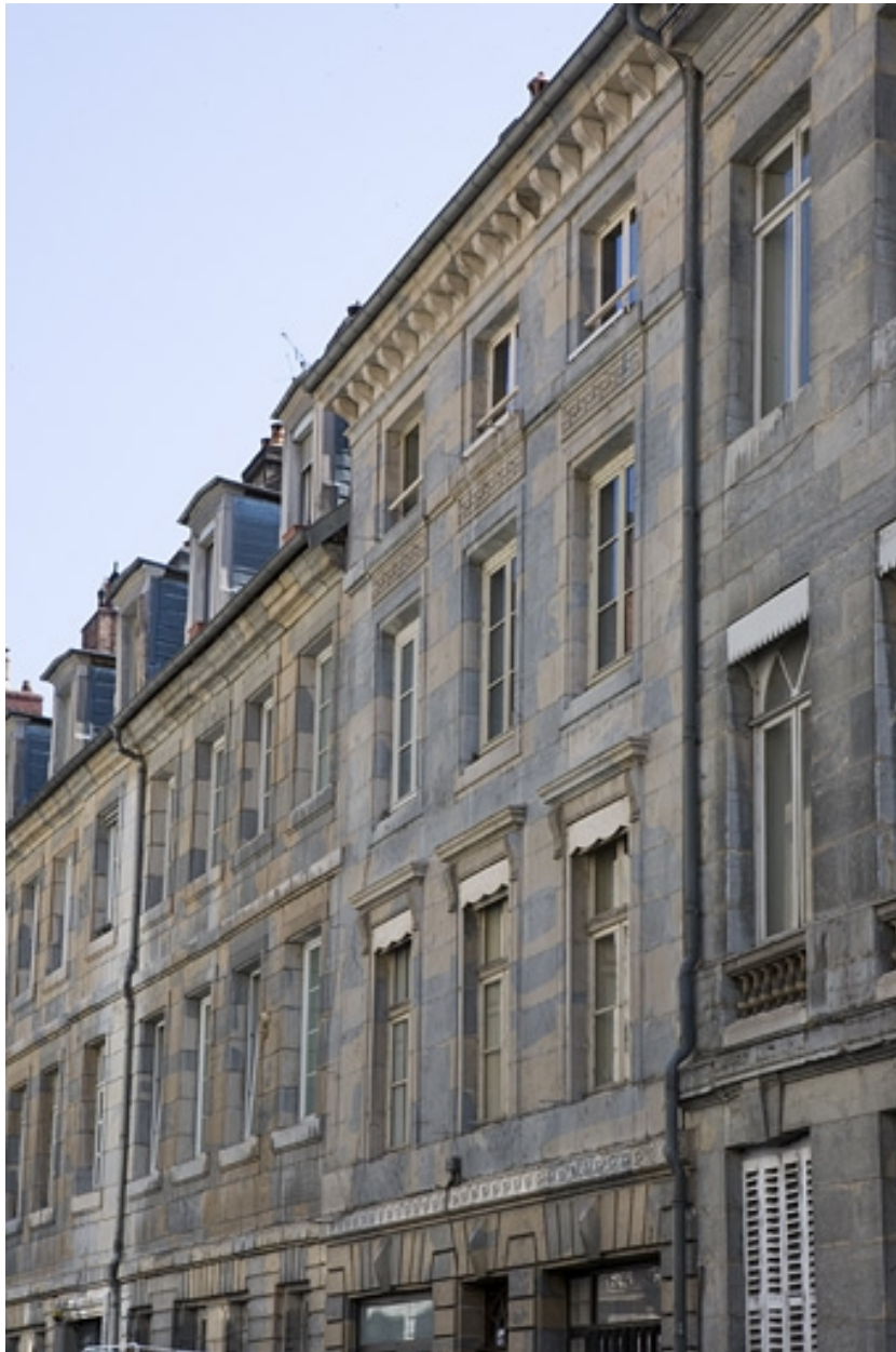
Vue rapprochée de la façade sur rue de trois quarts droit.
