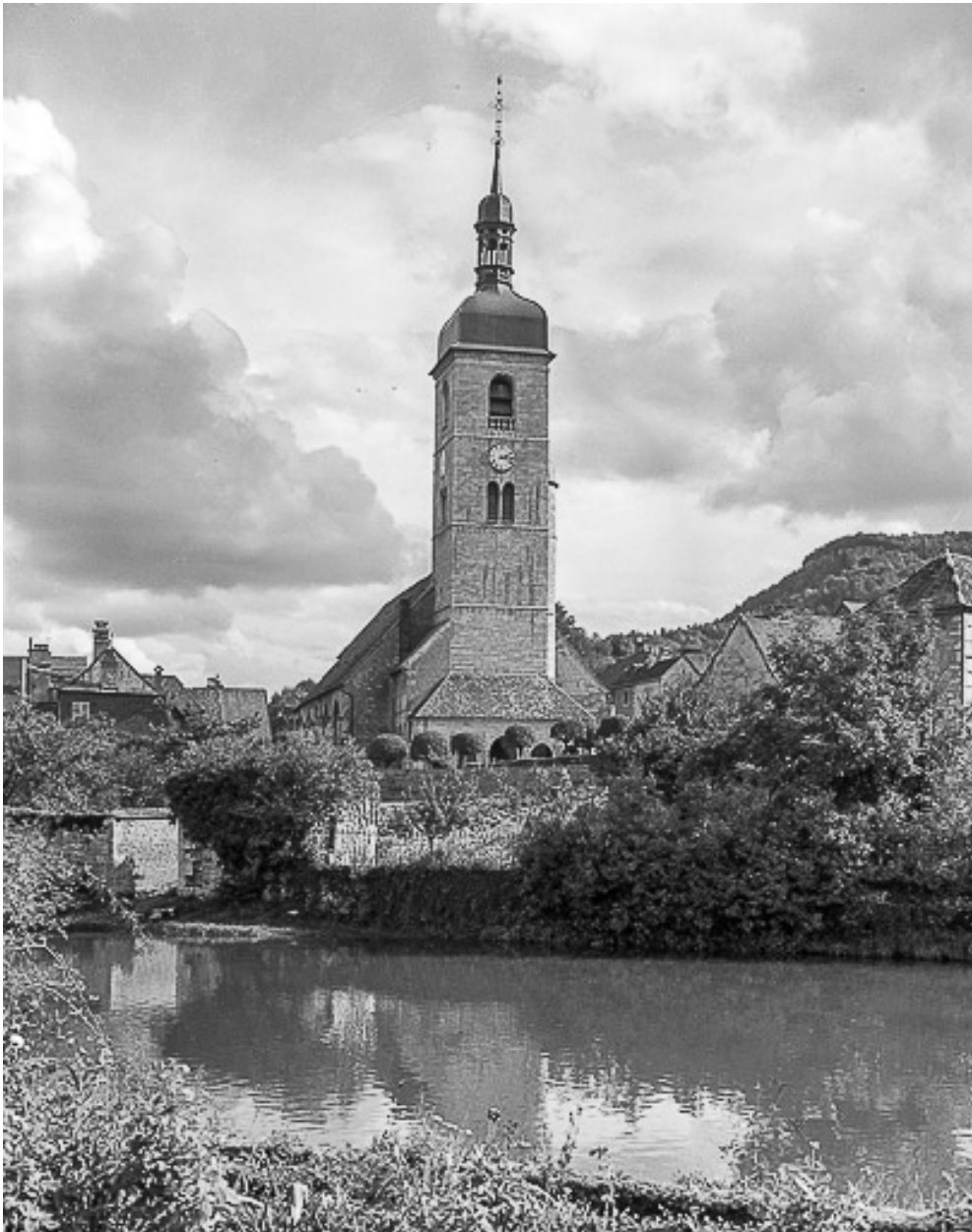
Vue générale depuis la rive droite de la Loue.
