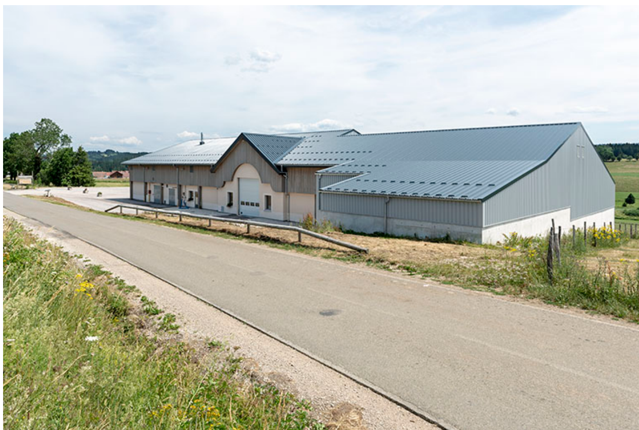
Façades postérieure et latérale droite.
