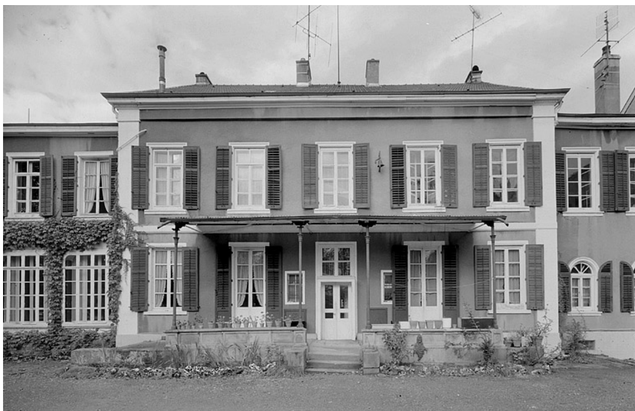
Façade sur jardin. Partie centrale.
