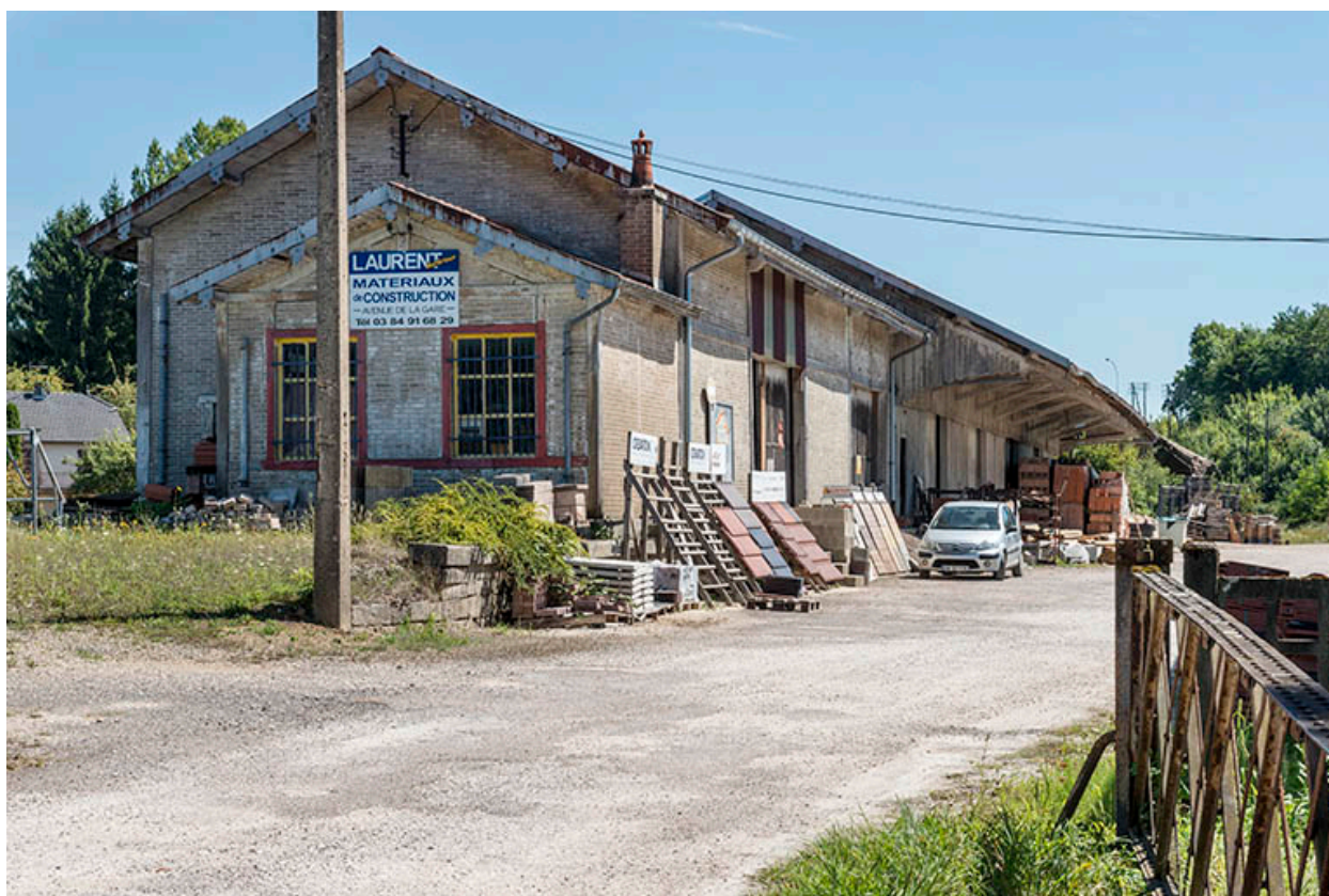
Vue depuis l'ancienne cour de la gare.
