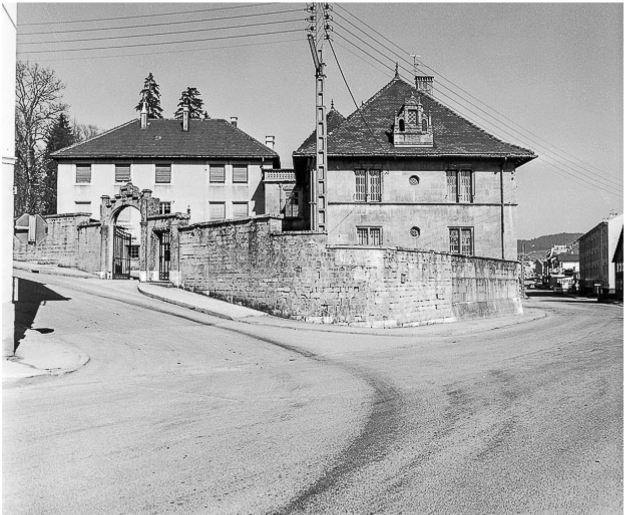
Vue d'ensemble depuis la rue, au sud-ouest.
