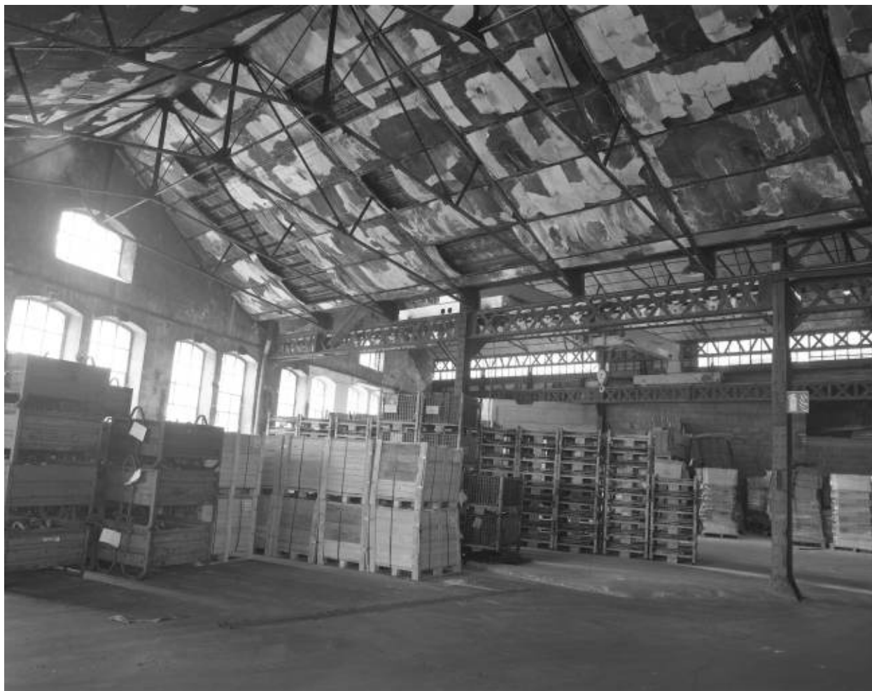
Ancienne fonderie. Vue intérieure générale.
