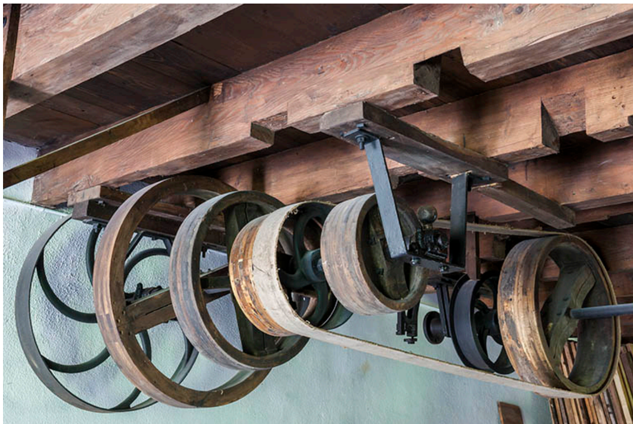
Détail de la transmission par poulies.
