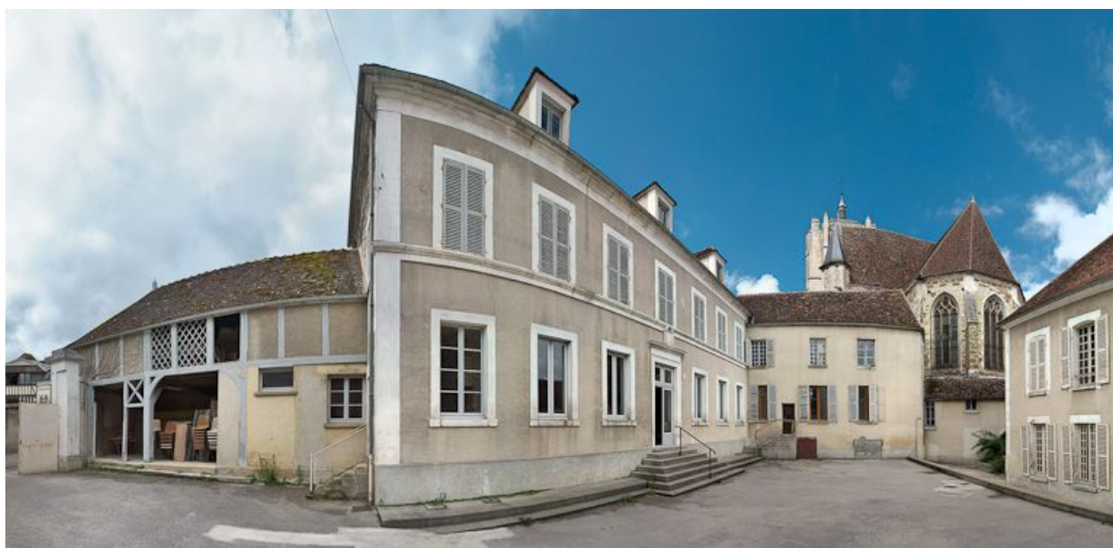
Vue d'ensemble des façades sur cour.
