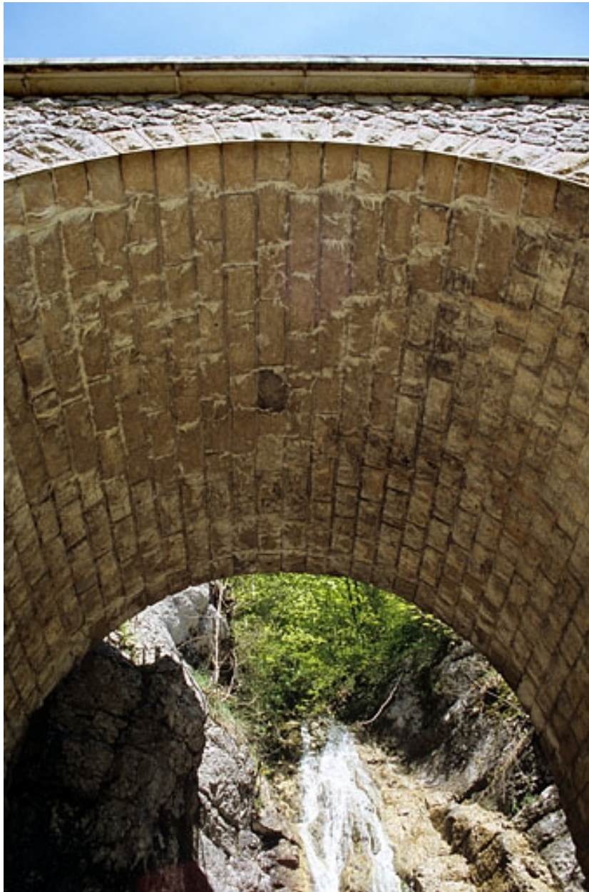
Viaduc : arche, vue du dessous.
