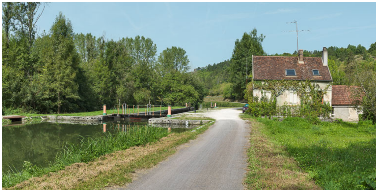
Vue du site d'écluse.
