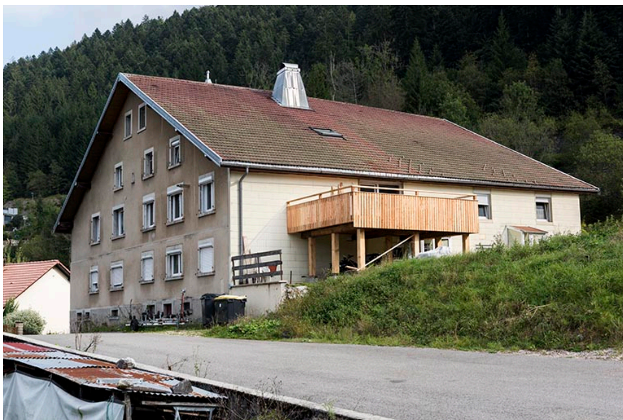
Façades postérieure et latérale gauche.
