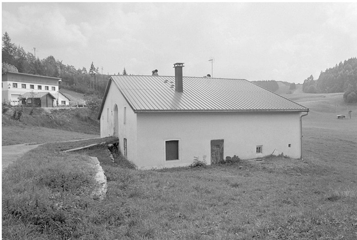
Façade postérieure et face nord-est.
