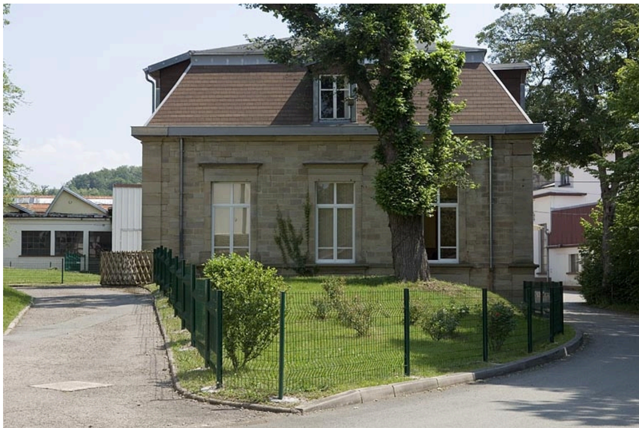
Ancien logement patronal, actuellement bureau.
