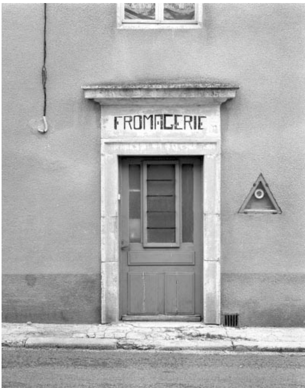
Porte d'entrée de la fromagerie.
