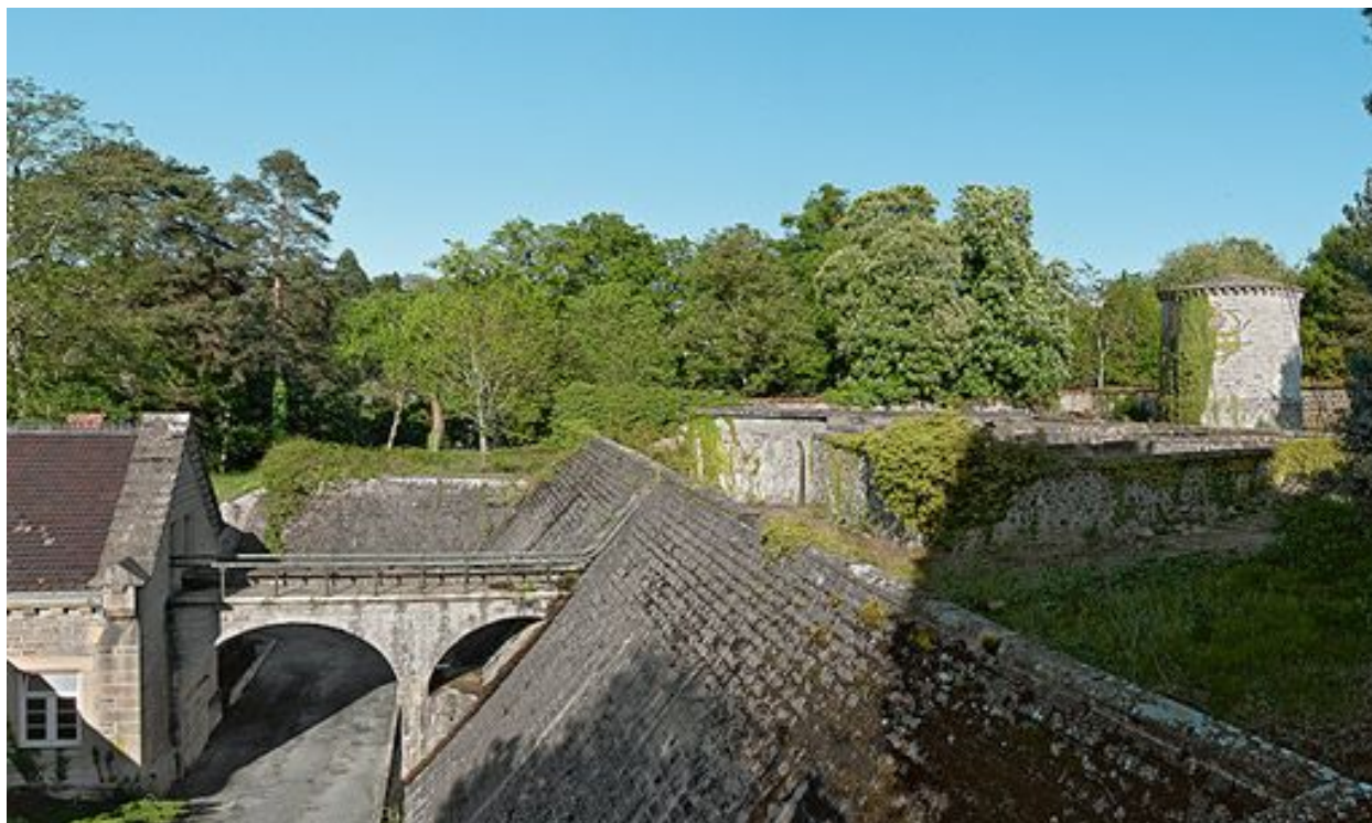
Vue d'ensemble du réservoir et du château d'eau (à droite)
