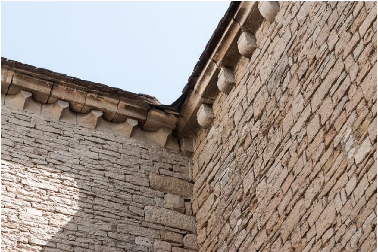
Corniche à modillons, à l'angle de la nef et du bras sud.
