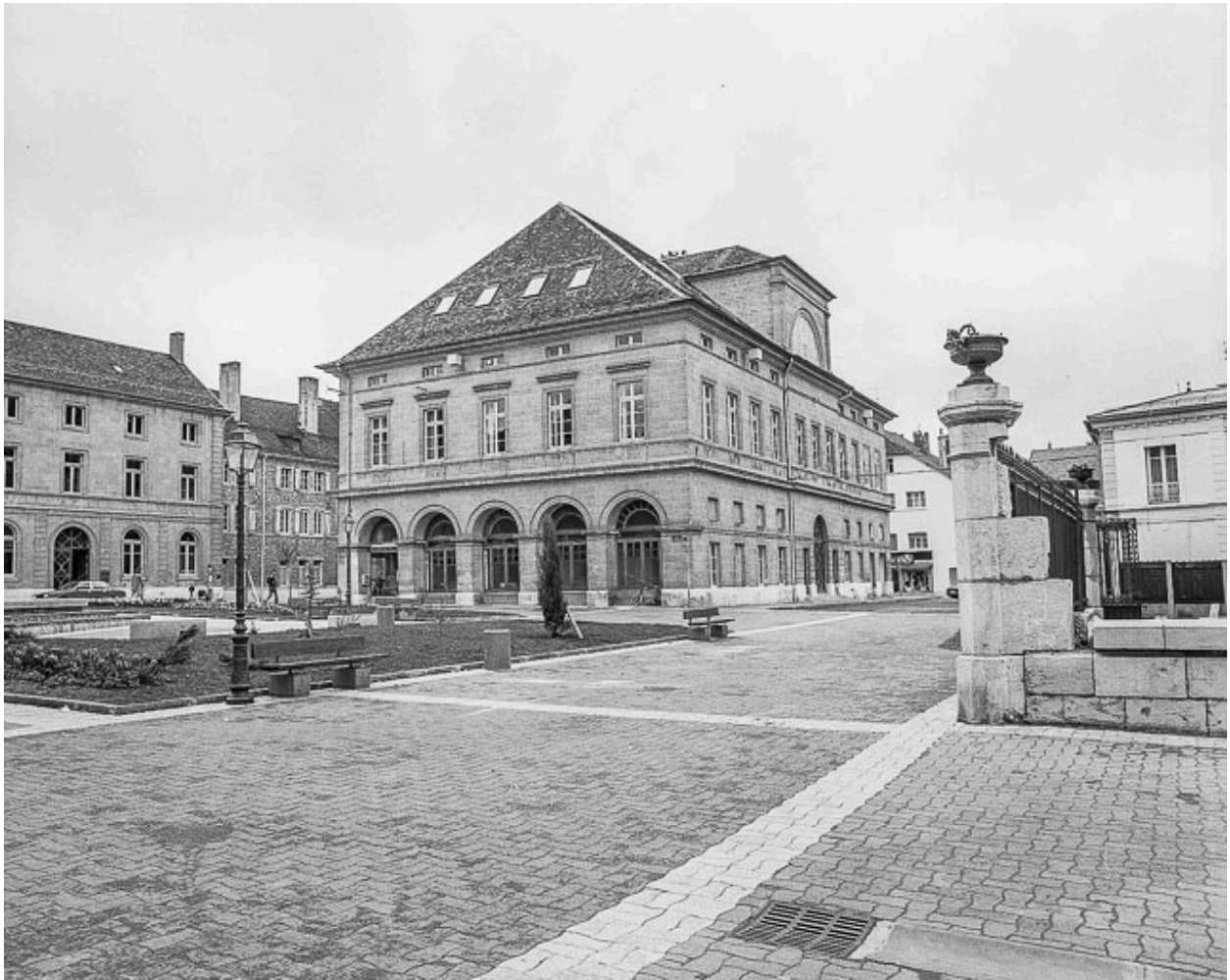
Façade postérieure et façade latérale droite.
