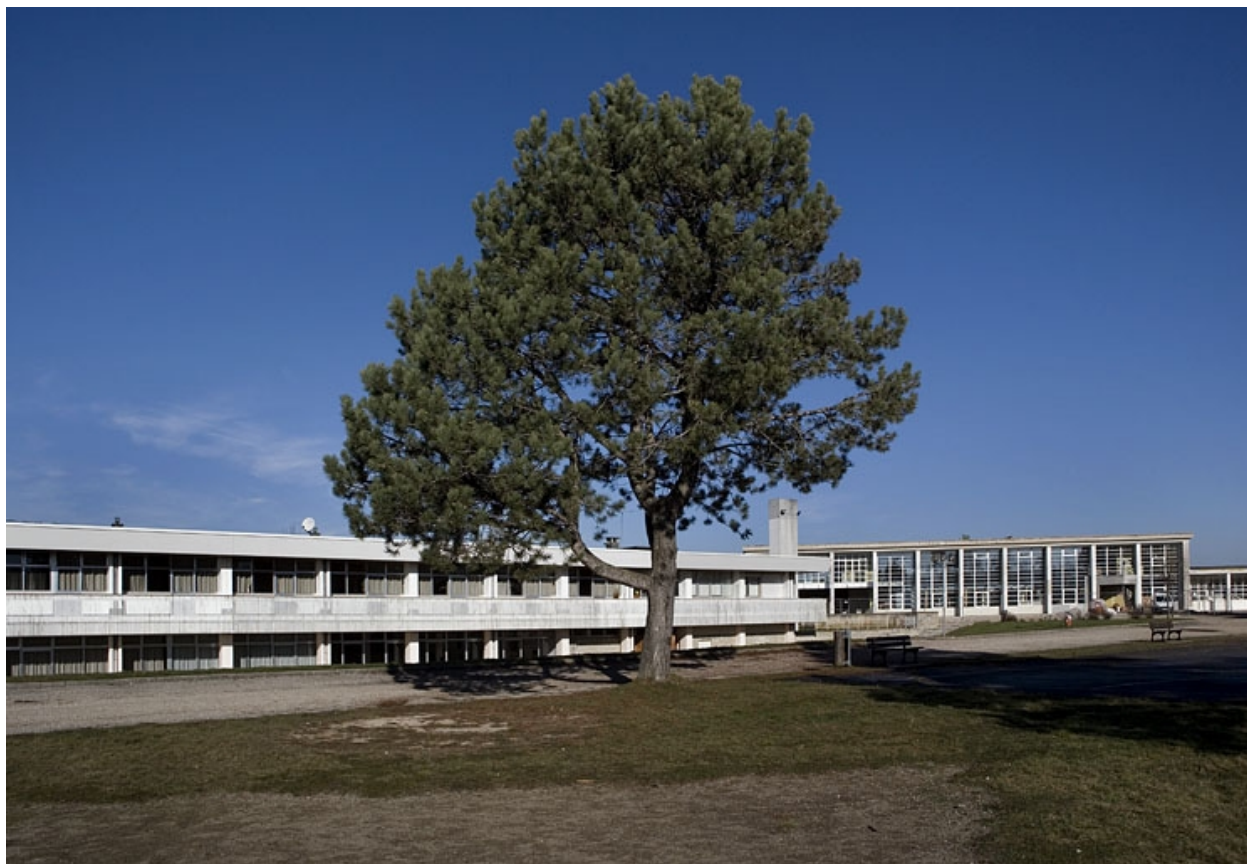
Vue générale des façades des bâtiments d'externat et d'internat.
