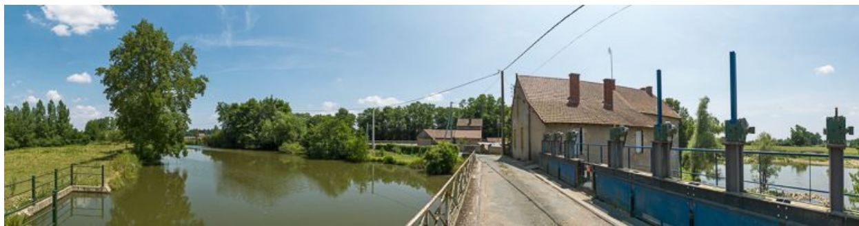
Barrage sur la Bourbince.
