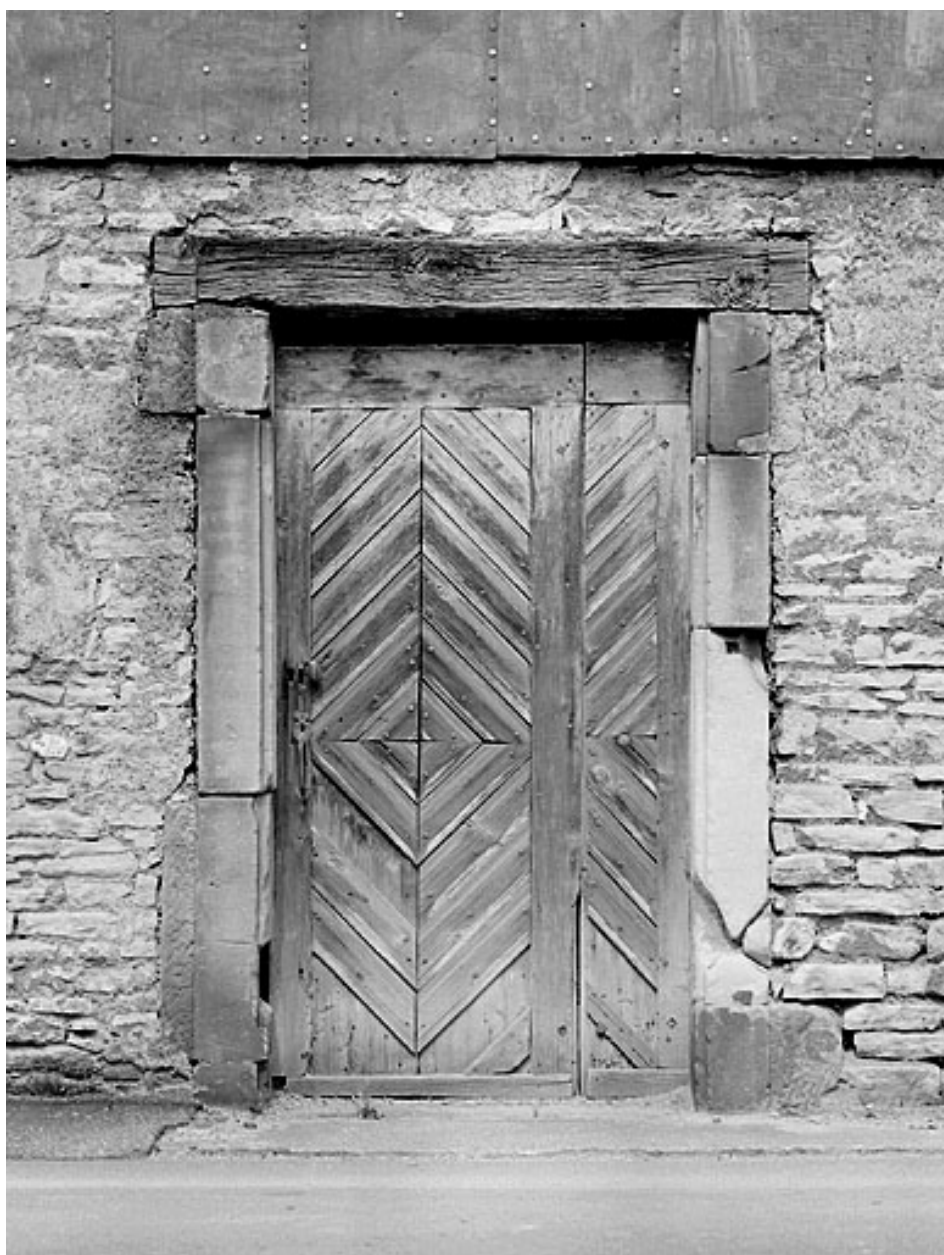
Atelier de menuiserie, porte sur la rue de la Synagogue.
