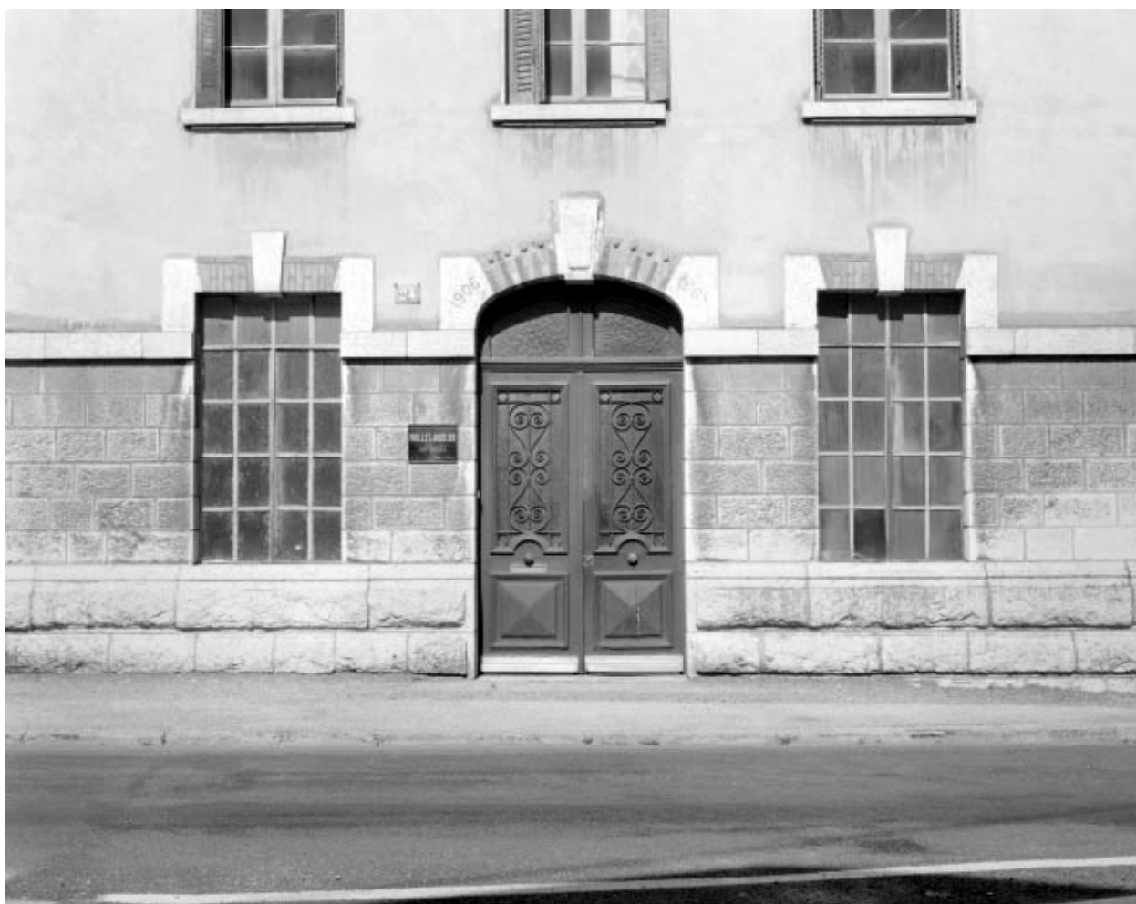
Entrée du 1er bâtiment.
