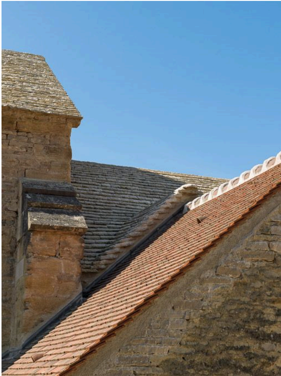
Détail des toitures du choeur, de la chapelle nord-est et de la nef.
