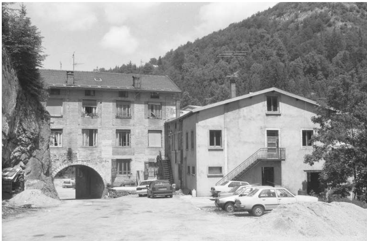
Vue d'ensemble depuis le sud-est (amont).
