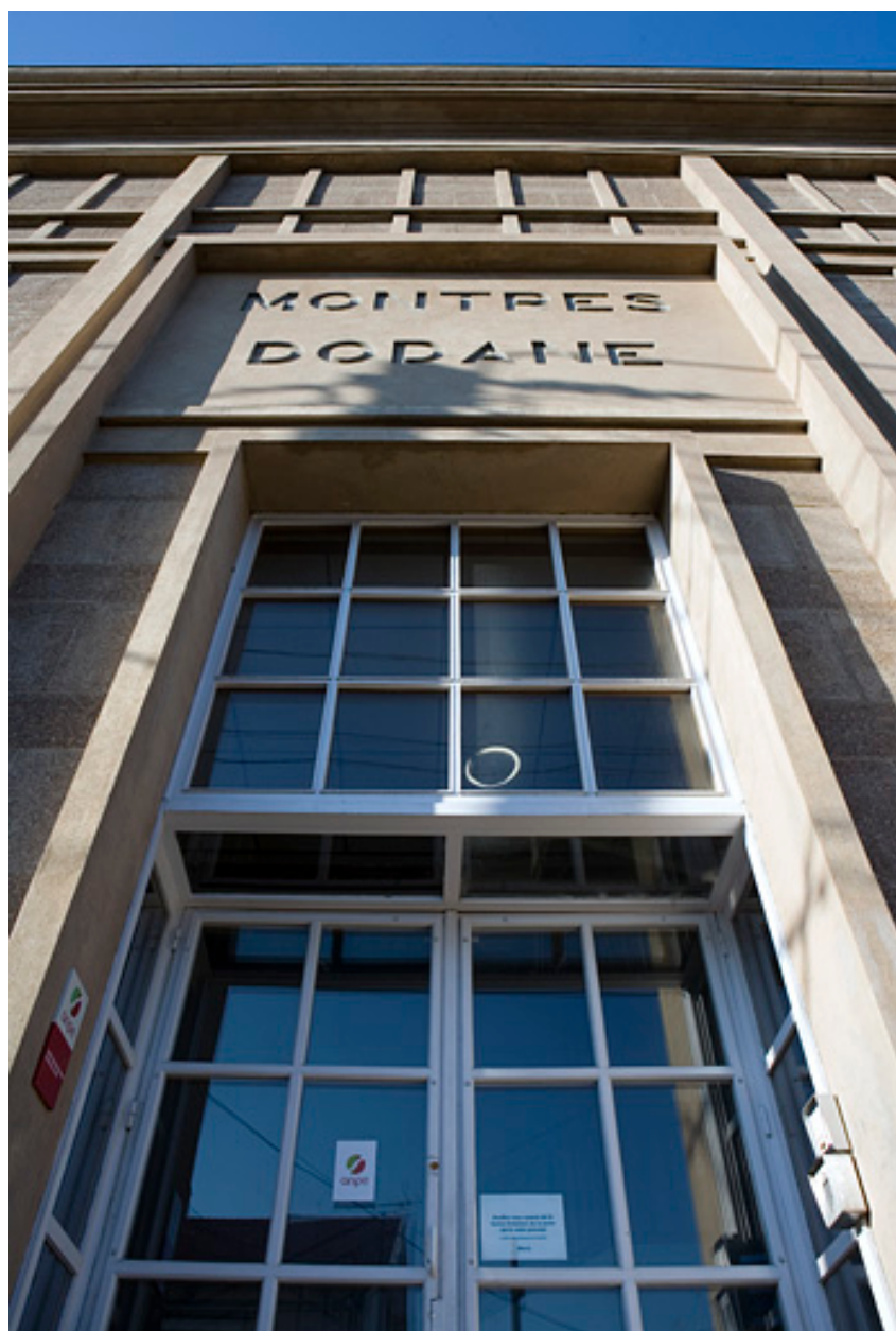
Usine d'horlogerie Dodane. Entrée vue en contre-plongée (5-7 avenue de Montrapon, Besançon).
