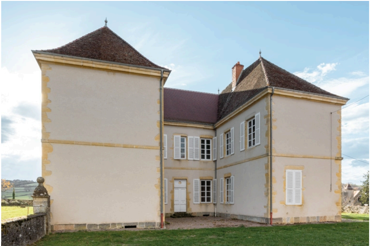
Façade nord-est du château
