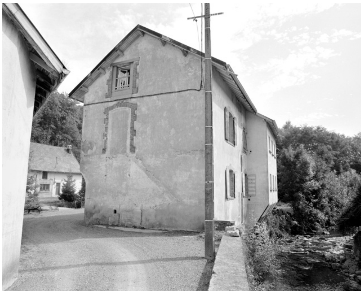
Logement d'ouvriers sur la rivière.
