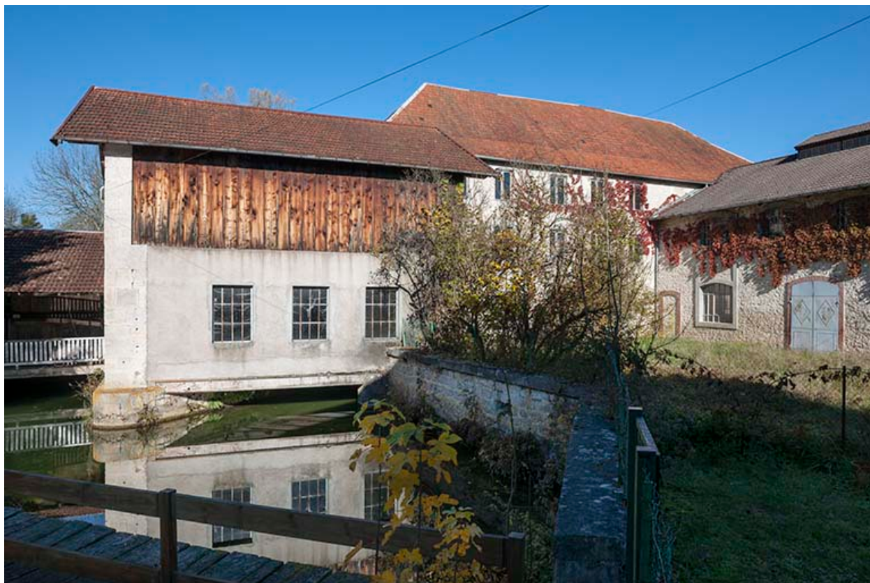
Bâtiment d'eau et atelier de fabrication.
