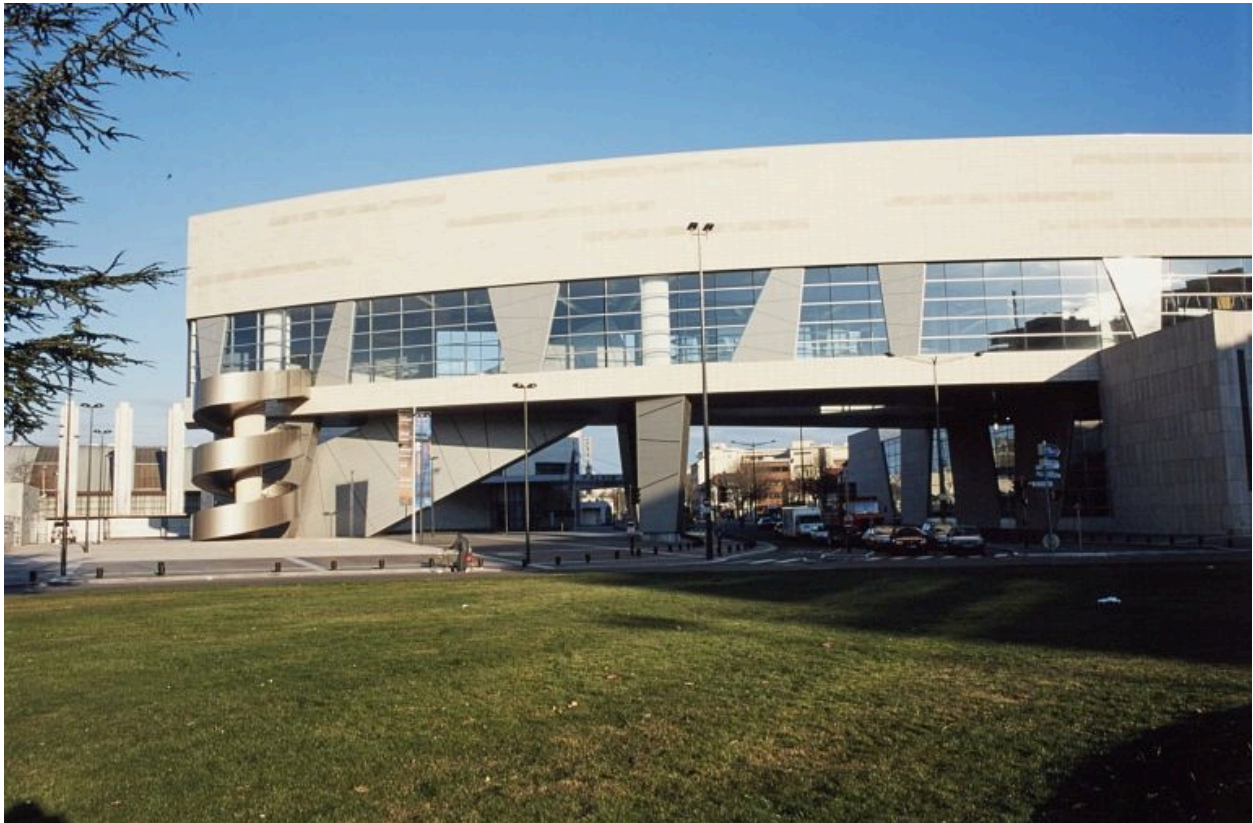
Elévation orientale du corps de bâtiment sur le boulevard de Champagne, depuis la place Jean-Bouhey, en 2000.
