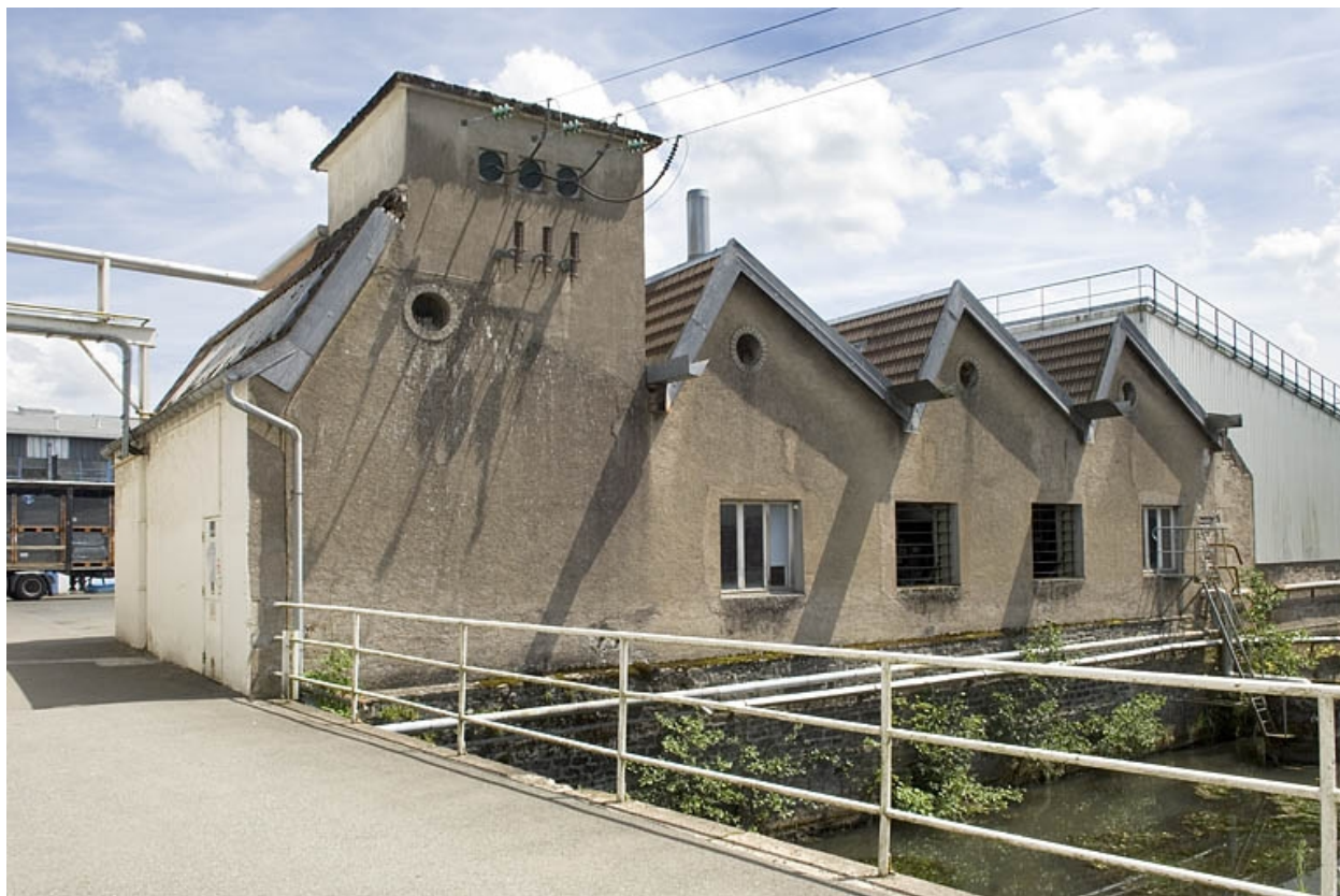
Atelier de réparation.
