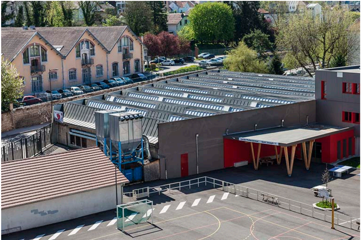
Vue plongeante sur les sheds de l'usine automobile.
