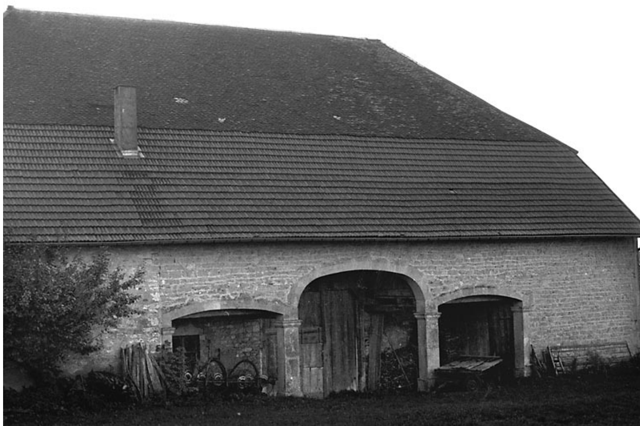
Vue du mur gouttereau droit.
