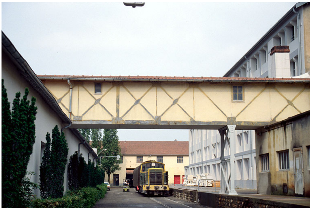
Façade antérieure de l'atelier (42), passerelle et locomotive.
