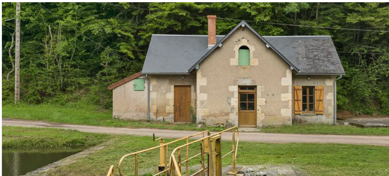
Vue de face de la maison éclusière.
