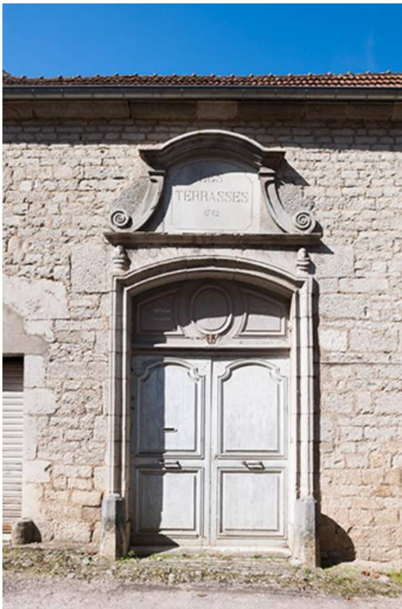
Porte du 6 rue du Bourg
