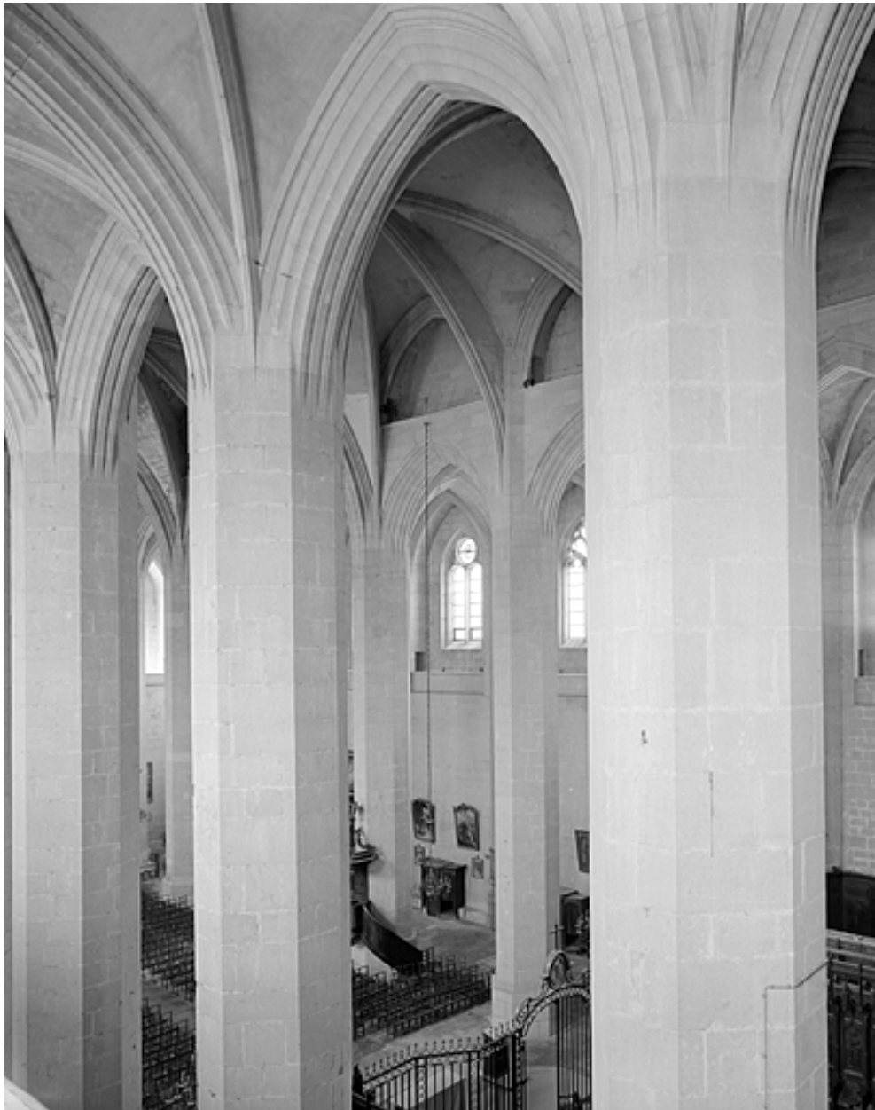
Elévation nord-ouest de la nef depuis la coursière basse.
